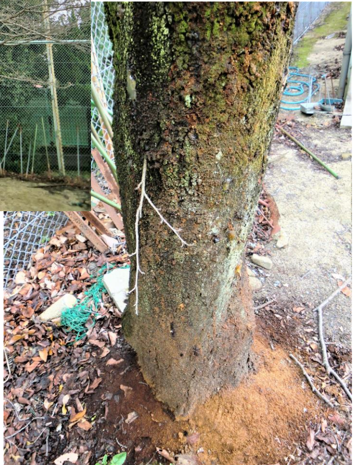
著しく被害を受けている
